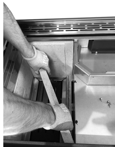
Fig. 70 - Retirer le matériau réfractaire
